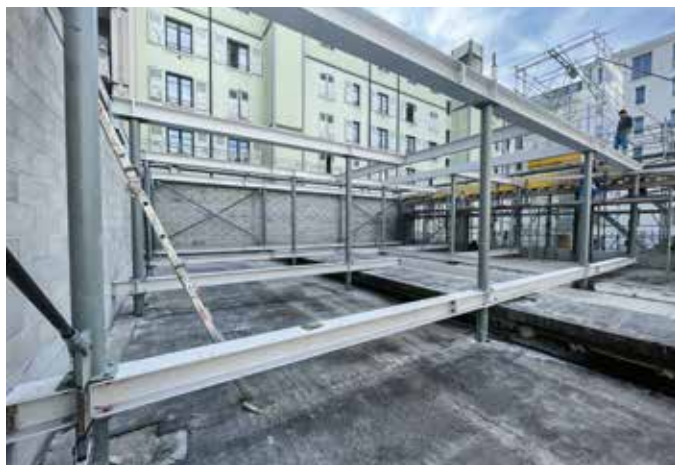
Vue du chantier. Comme le bâtiment existant ne peut supporter la surcharge d'un étage supplémentaire et la végétalisation de la toiture, architectes et ingénieurs imaginent un endosquelette métallique traversant l'existant, ancré sur une série de micropieux. (CDAO)
